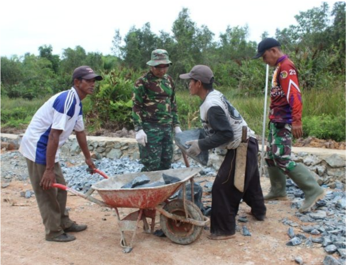
Personel Satgas TMMDKe - 117, Kerjakan Siring Jalan
